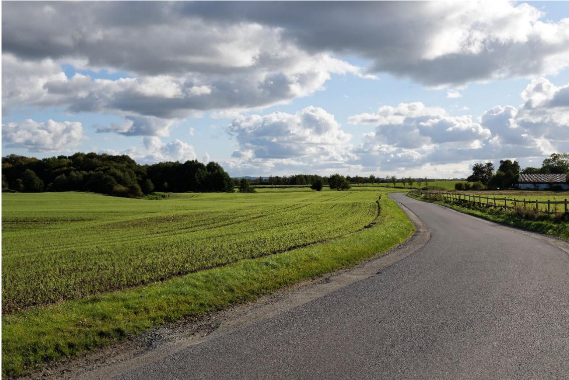
Figur 7-21 Visualiseringspunkt 7 – eksisterende forhold. Visualiseringspunkt 7 viser morænelandskabet med ejendommen Birkemosevej 37 samt et samlet beplantet område til venstre i billedet.
