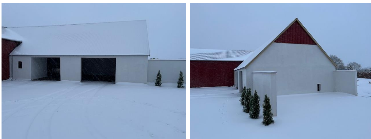
Billeder af carporten efter ombygningen, jf. ansøgningen
