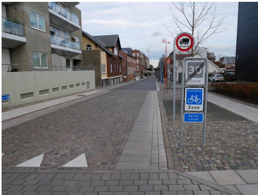
Cykelgade og cykelfliser (Esbjerg).
