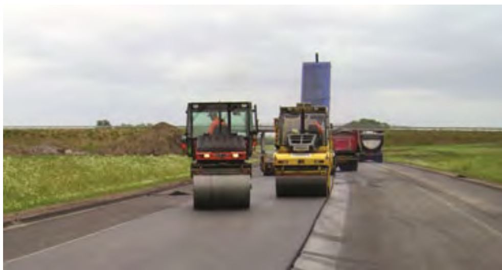
Figur 6.7 Anlægsarbejder på en vejstrækning.
