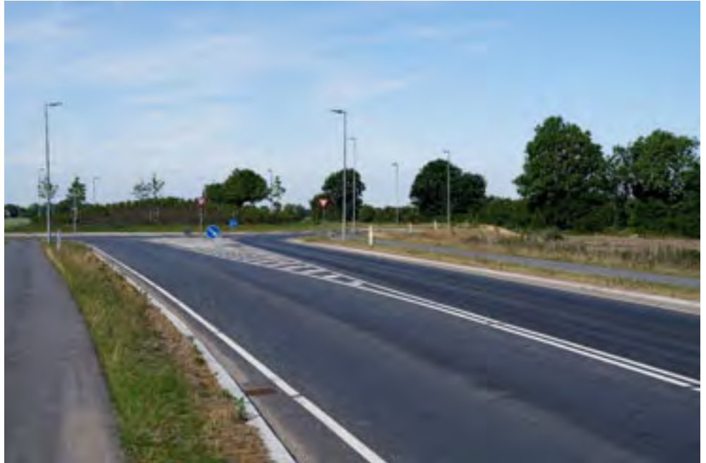
Figur 7.12 Den eksisterende rundkørsel på Vonsildvej. Mod øst (til højre i billedet) findes et dige med varieret bevoksning, der skærmer udsynet over landbrugslandskabet her.
