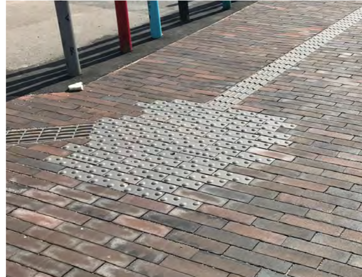
Eksempel taktile belægning i klinker Benyttes i gaderum for der er fortorv og kørevej.
