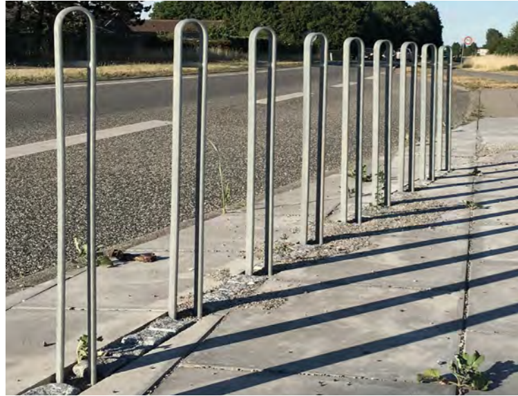
A-cykelstativ & pullert (med flere tværgående rundjern)
