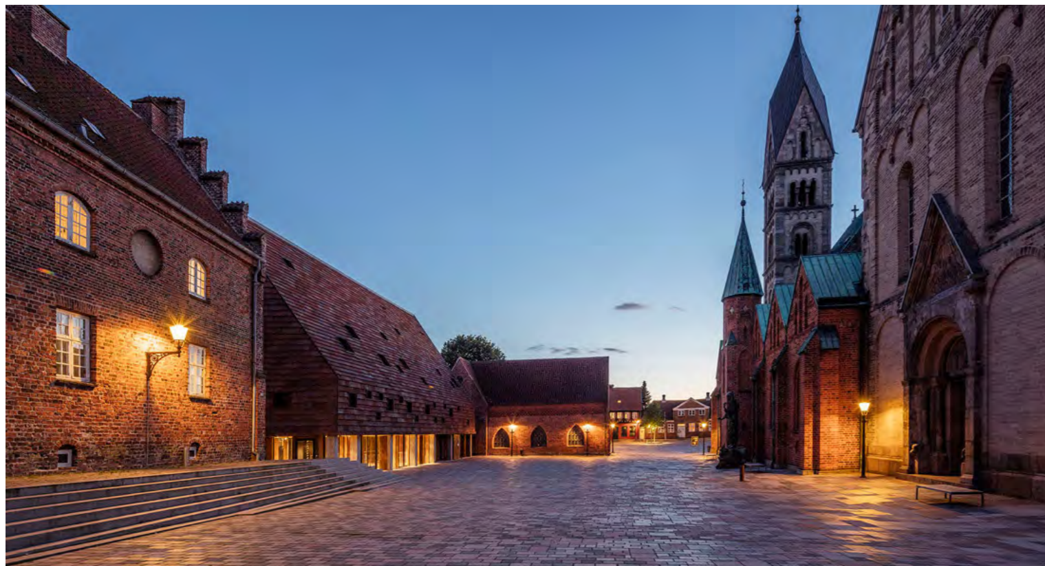
Reference fra Ribe hvor en historisk plads er blevet renoveret varm belysning og støbejerns master og ameratur
