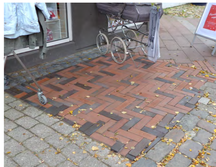
Prøvefelt af gågadens fremtidige belægning Det er vigtigt at finde den helt rigtige farvesammensætning
