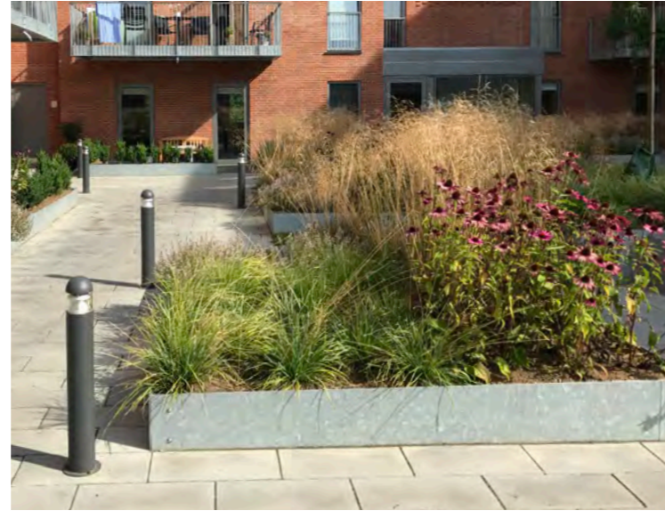
Plantehuller indbygget i belægningen med ramme i sølvfarvet stål
