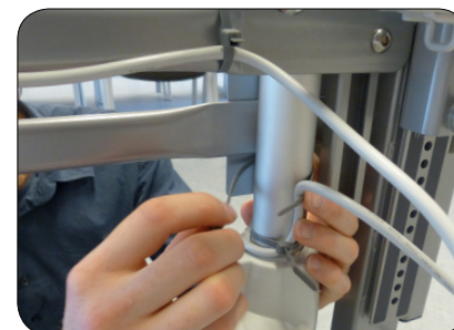
Placer aktuatorkablet på bagsiden af aktuatoren med strips
